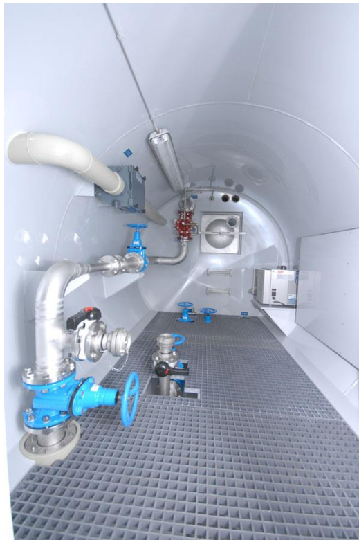
Beispiel einer Schieberkammer aus PPC (Bild aus Webseite HWT)
