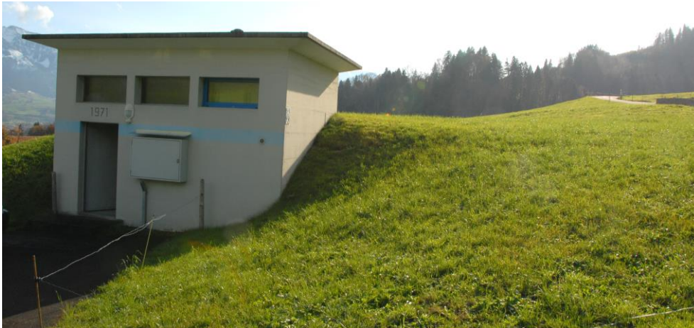
Abbildung 1: Bestehendes Reservoir, Blick nach Süden
