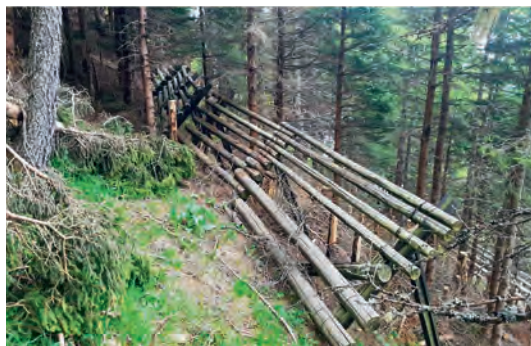
Zerbrochene Hölzer beim Schrotsboden
