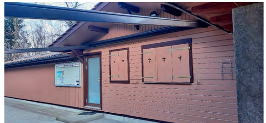
Badibeiz nach Sanierung im März 2022
