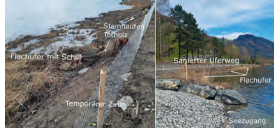
Gestaltung Flachufer, Sanierung Uferweg und Erstellung Seezugang
