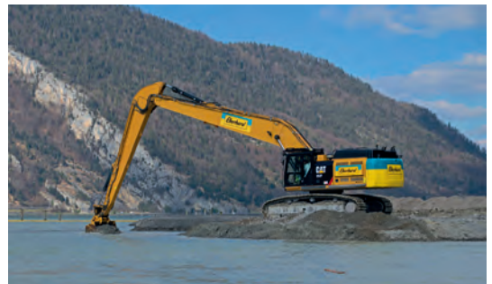
Der imposante, 70 Tonnen schwere Langarmbagger wird in diesen Tagen abtransportiert und auf eine nächste Baustelle gebracht
