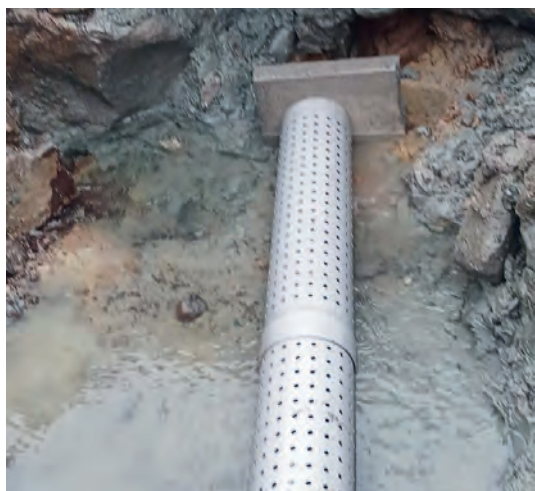
Ende Quelfassung mit sichtbarem Quellwasser
