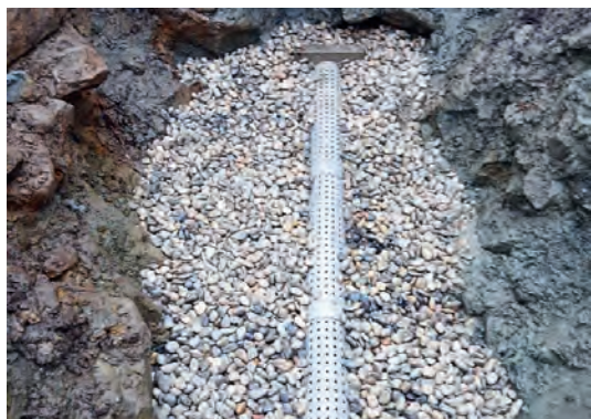
4 m lange Quelfassung mit Fassungsohren und Filterkies
