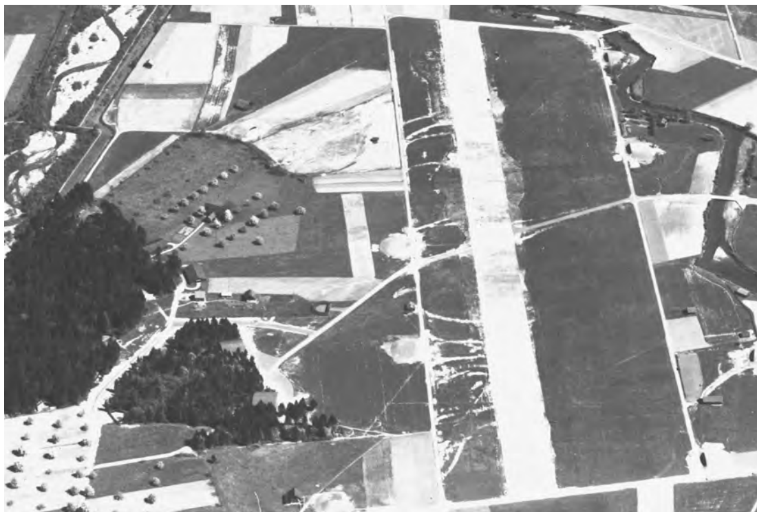
Die erste Hartbelagspiste von 875 Metern Länge wurde im Jahre 1943 gebaut und eröffnet
