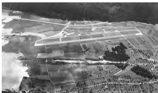
Neue Flugzeuge verlangten eine Pistenverlängerung auf 1'500 Meter, welche ohne grosse Bauten im Jahre 1955 realisiert wurde.
