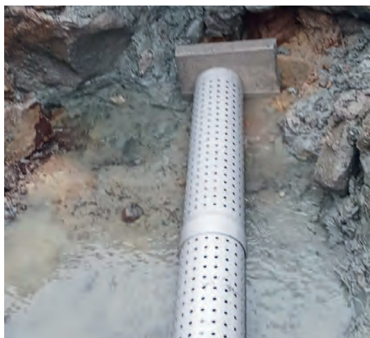
Ende Quelfassung mit sichtbarem Quellwasser
