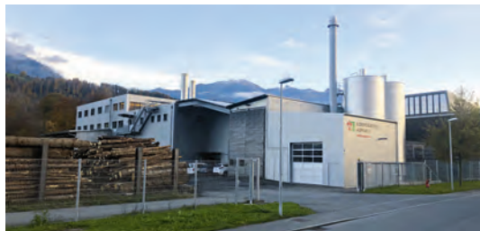
Holzheizwerk Korporation Alpnach
