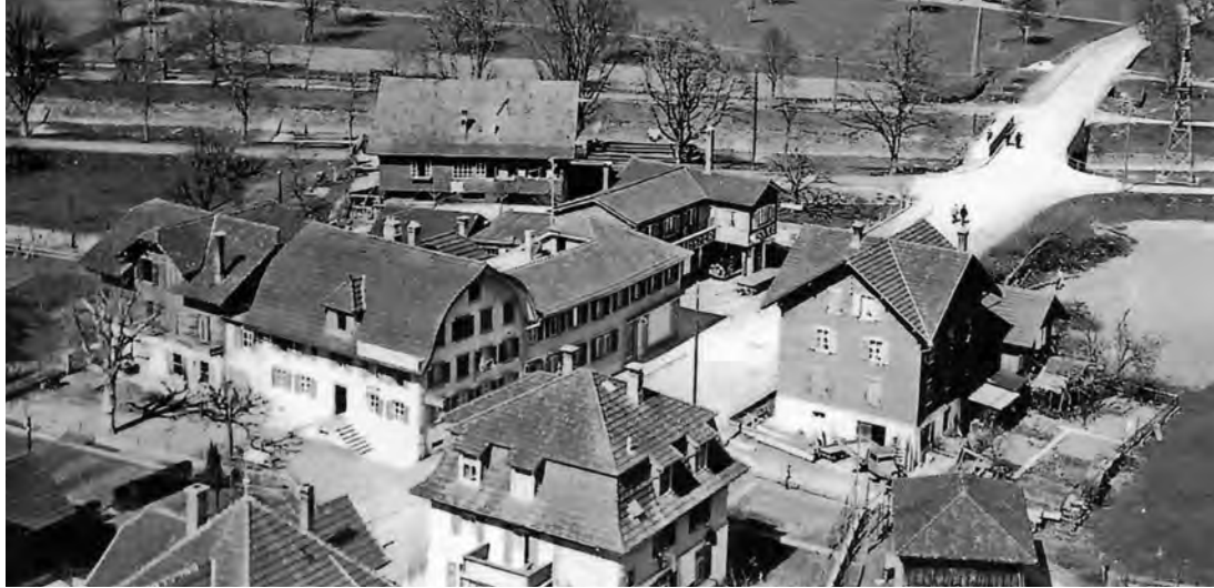
Erste offizielle Tankstelle im Dorf Alpnach der Garage Fischer ca. 1937. Unser Bild zeigt eine Aufnahme von 1940 mit dem Restaurant Sonne/Metzgerei, dem Haus mit der Wagnerei von Atzigen und dem damaligen Schuhhaus Bucher
