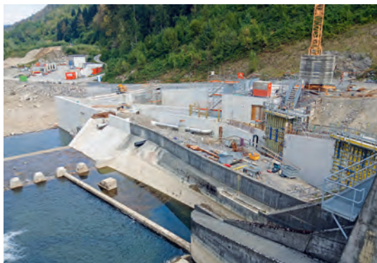
Stand der Bauarbeiten Ende August beim Stauwehr. Erste Arbeiten zum Bau des Fischabstiegs sind bereits ausgeführt.
