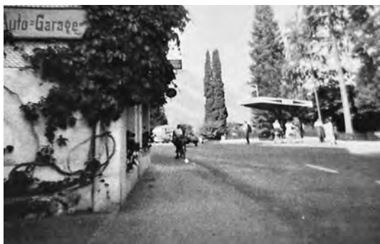
Die Tankstelle gegenüber dem Hotel Pilatus von Urban Dall'Omo ebenfalls im Stad
