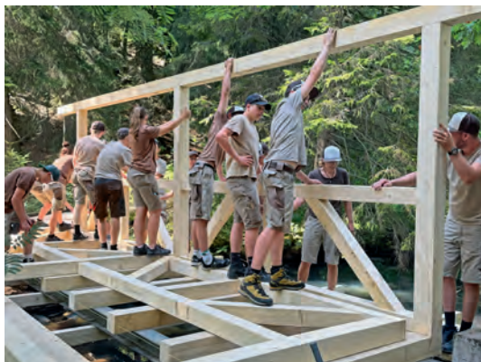
Aufrichtearbeiten Holzbrücke
