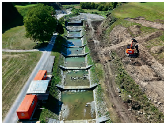
Geschiebetriebkanal Chlewigen bis Mündung Meisibach
