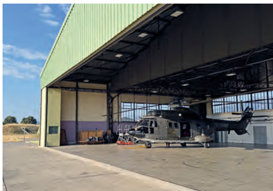
Bereitstellung im Hangar
