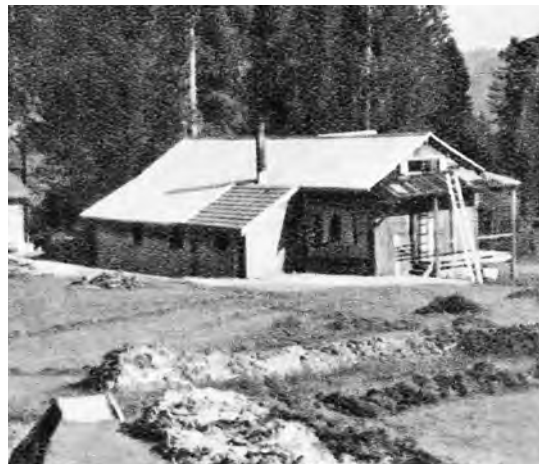
Das Barackenlager für die Arbeiter auf Neubrüchli
