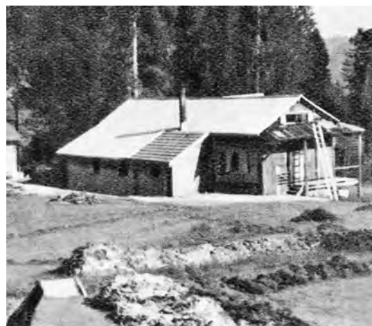
Das Barackenlager für die Arbeiter auf Neubrüchli
