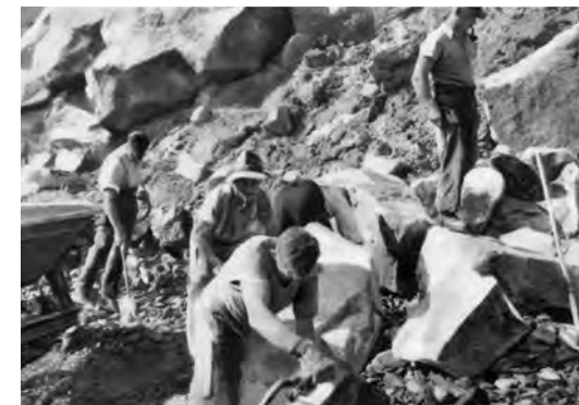
Arbeiten im Jahre 1938 in einem Steinbruch auf der Alp Neubrüchli
