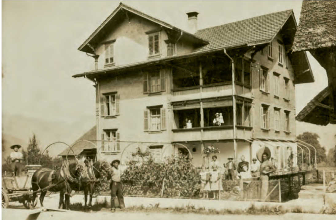
Ansicht des Wohnhauses Neuheim, (Baujahr 1903) Grund, im Jahre 1910. Am rechten Bildrand ein Teil des Oekonomiegebäudes mit Käsekeller. Damaliger Besitzer Meinrad und Mathilde Wallimann-von Rotz mit Familie vor dem Haus.
