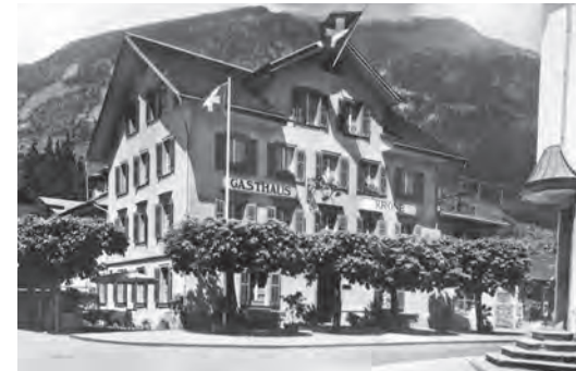
Das Gasthaus Krone vor den zwei grösseren Umbauten in den Jahren ca. 1930–1960.
