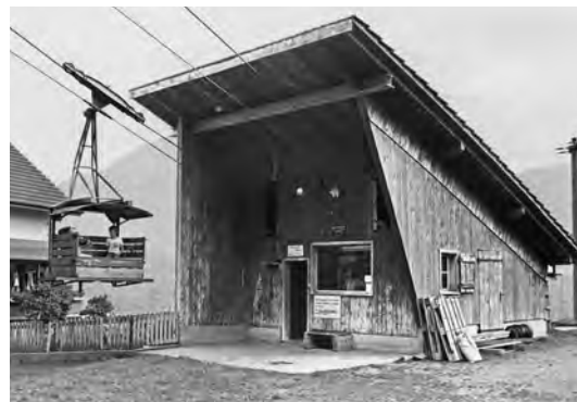
Talstation nach dem Umbau auf Doppelspur für Personen- und Materialtransporte
