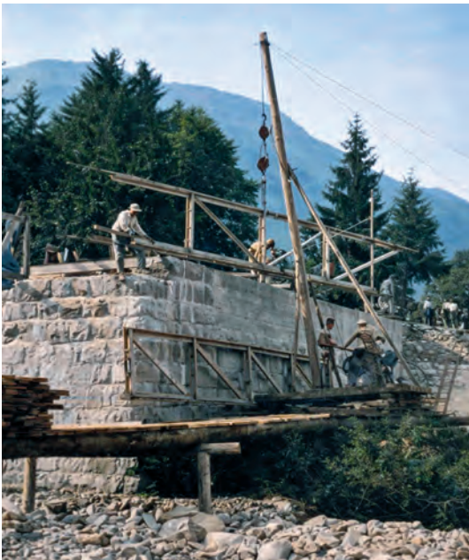
Baustelle Geissfusssteg Schoried
