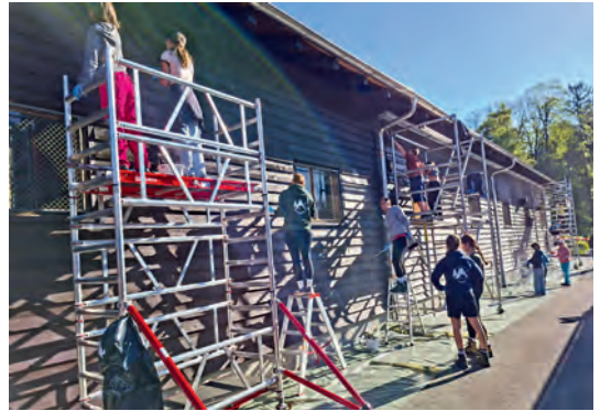
Streicharbeiten an der Werkhoffassade
