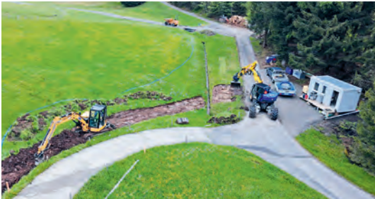
Bauarbeiten im Gebiet Heiti
