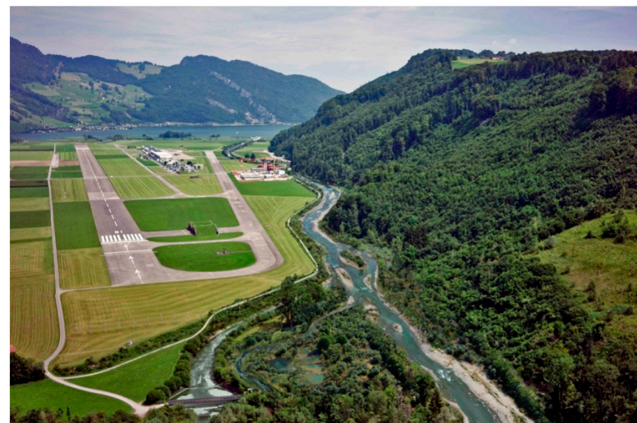
Kanton Obwalden, Wasserbauprojekt Sarneraai
