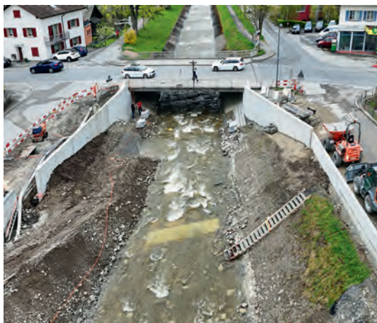
Seitliche Mauern bei der Brücke der Kantonsstrasse Bild: belop gmbh/Seppi Berwert-Lopes
