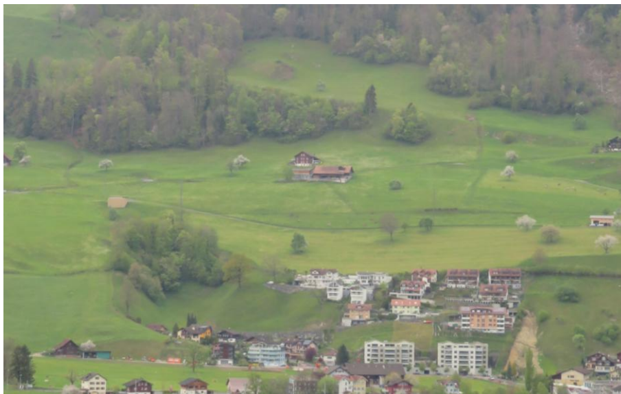
Gegenhanaufnahme in Richtung Bauparzellen Chälenrain (belop gmbh, 24.04.2022).
