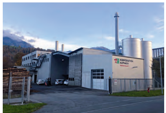
Holzheizwerk Chilcherlistrasse 8, Alpnach
