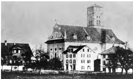
Die heutige Pfarrkirche nach dem Turmbrand von 1887 mit dem Notdach, welches eine vollständige Zerstörung der Kirche verhindert
