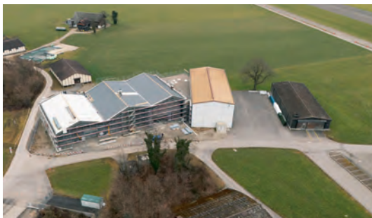
Baufortschritt Stand Februar 2026
