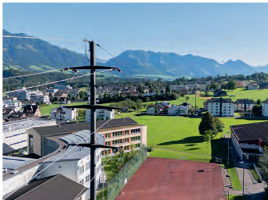
50 kV-Freileitung
