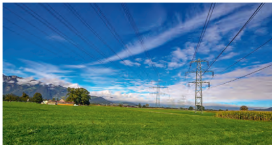
Hochspannungsleitungen sollen unter die Erde verlegt werden
