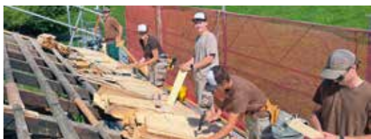
Tatkräftige Mithilfe beim Eindecken des neuen Schindeldachs im Freilichtmuseum Ballenberg
