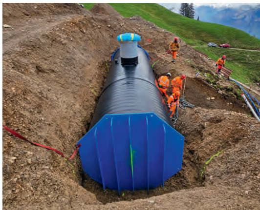
Das vorfabrizierte Wasserreservoir mit 20 m³ Speichervolumen (knapp 10 m lang, Aussendurchmesser 2.5 m) ist am Bestimmungsort oberhalb der hinteren, oberen Chretzenalp platziert.
