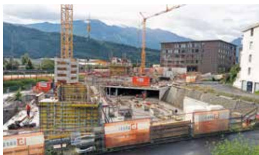
Überblick über die Baustelle Allmendweg 6, 8 und 10
