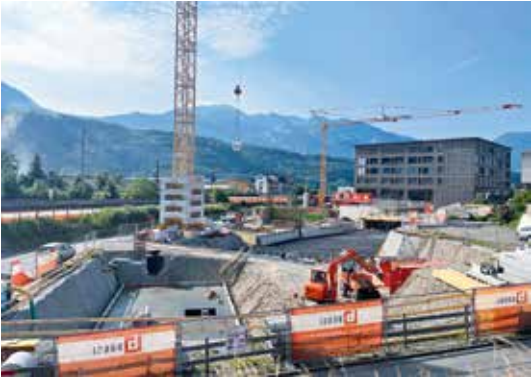
Aktueller Stand der Bauarbeiten Mehrfamilienhäuser Allmendweg 6, 8 und 10.
