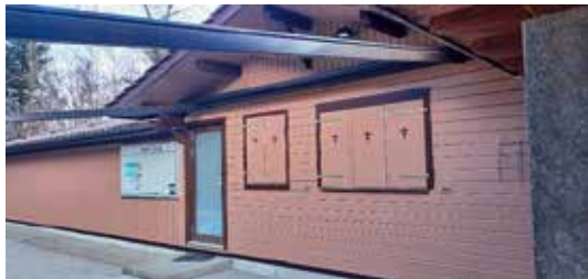
Badibeiz nach Sanierung im März 2022
