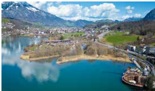
Einlaufbauwerk in Sachseln
