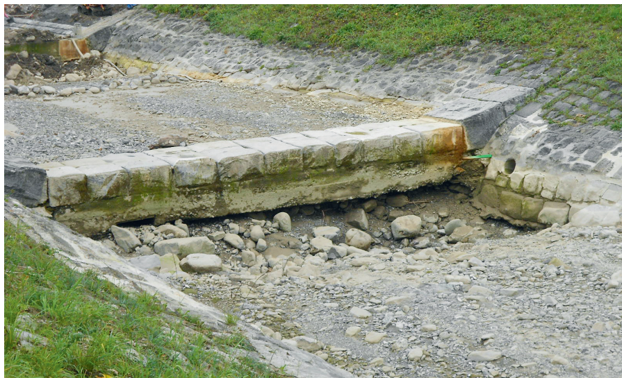
Beschädigte und unterspülte Einzelschwelle im Schlierenkanal
