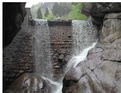
Hochwasserschutz Kleine Schliere
